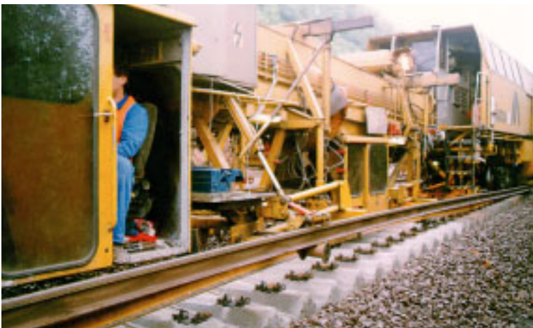
Automatisierter Einbau der Breitschwellen
