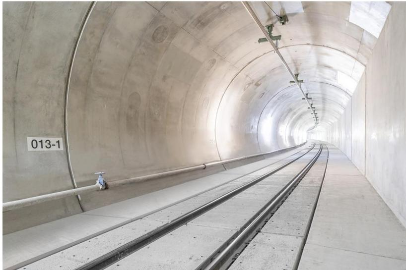
Bildunterschrift 1: RAILONE Sicherheitssystem ROSS installiert bei dem Projekt Stuttgart 21 (Foto: PCM RAILONE AG/R.Mederer)
